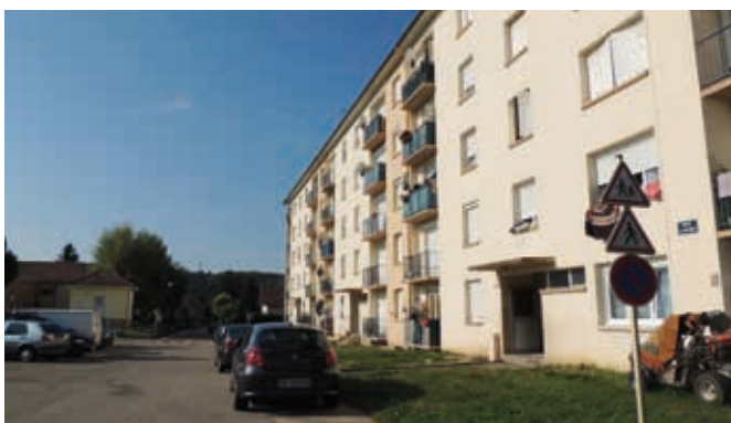
La réhabilitation énergétique du parc existant, de logements publics comme de logements privés (en photos la copropriété IDEE à Didenheim), est un objectif majeur du PLH
