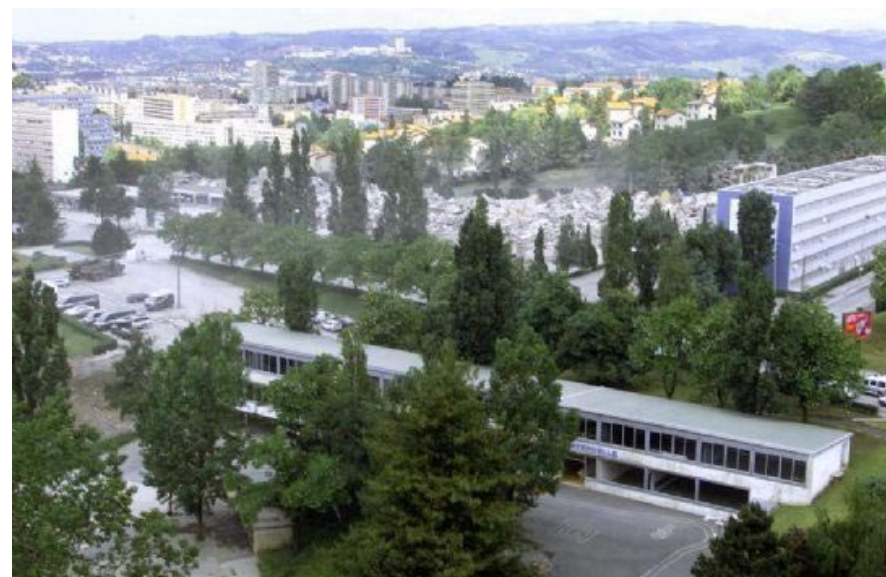
Démolition de la " Muraille de Chine " Zus Montchovet -St Etienne source : www.lexpress.fr
