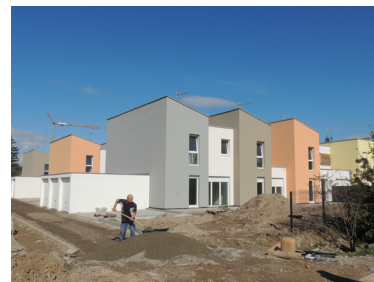
Logements sociaux en construction, Mulhouse
