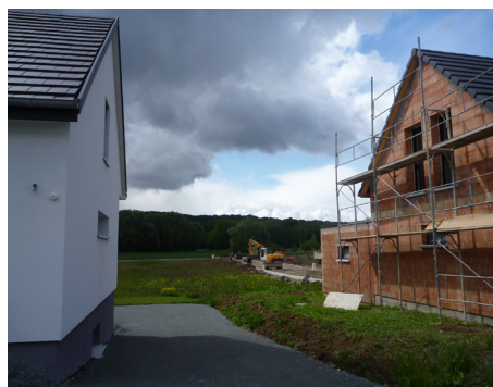
Pavillon en construction dans un petit lotissement à Steinbrunn-le-Bas, 2014
