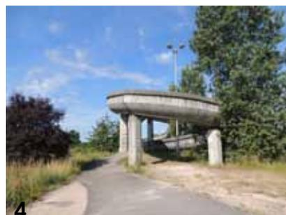
L'ouvrage en béton et en spirale est peu large pour un usage par les cyclistes. La pente importante est aussi un frein à son utilisation.
