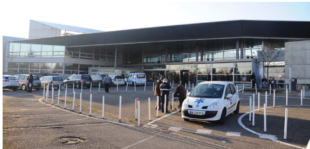
L'hôpital Emile Muller est situé à Mulhouse, au sommet du Rebberg.
