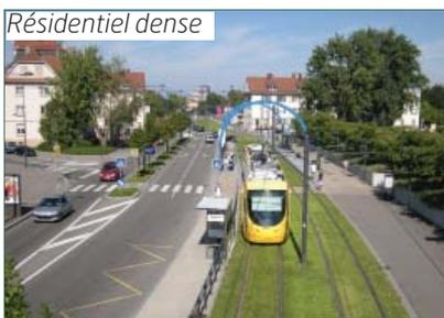
**Mulhouse – bv. Stoessel** : principe de séparation des flux = voiture, plate-forme tramway, piste cyclable, trottoir.
