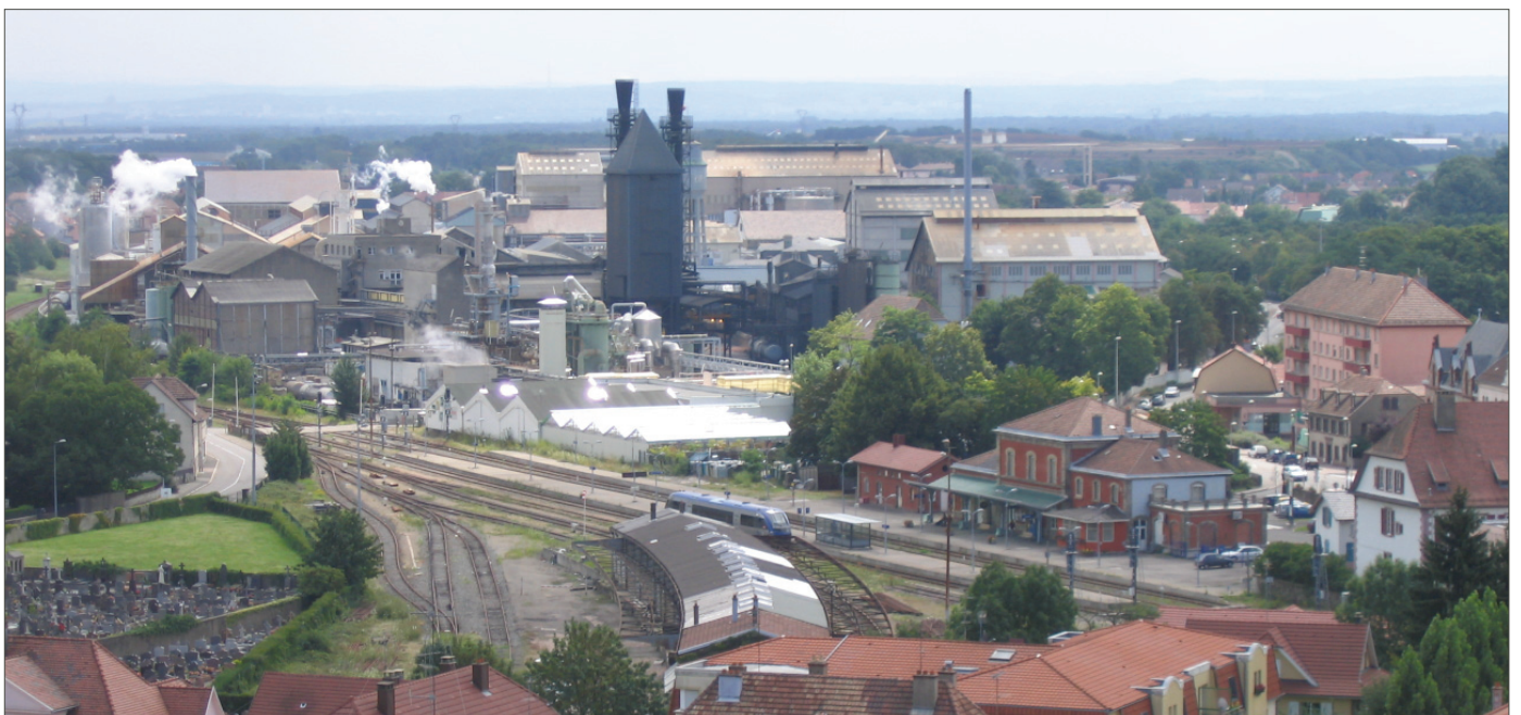
L'usine PPC Vyonna couvre près de 8 ha à Thann et compte plus de 200 salariés. Le site a été créé en 1808.
