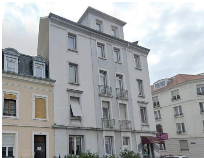
Avenue Roger Salengro, Mulhouse - chauffage individuel électrique
