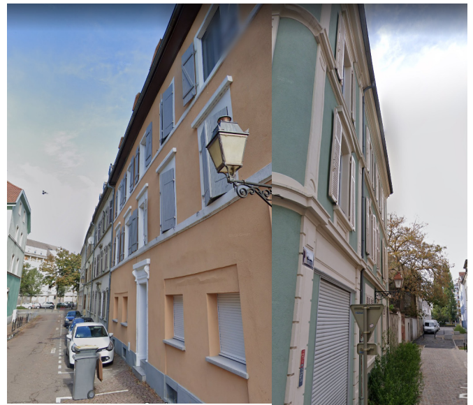
Rue des chantiers et rue de rabbins à Mulhouse - Fonderie
