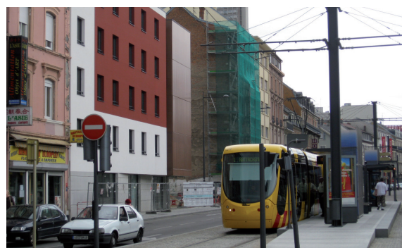
Avenue de Colmar après les travaux réalisés dans le cadre de la ZAC Casquettes
