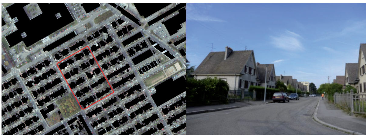
Cité ouvrière entre la rue Louise et la rue Madeleine, Mulhouse : 53 logements/ha
