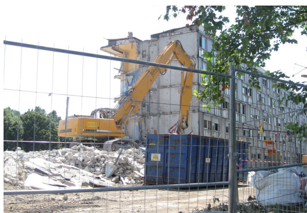
Démolition d'une des barres des 420 –Bourtzwiller (juillet 2010)
