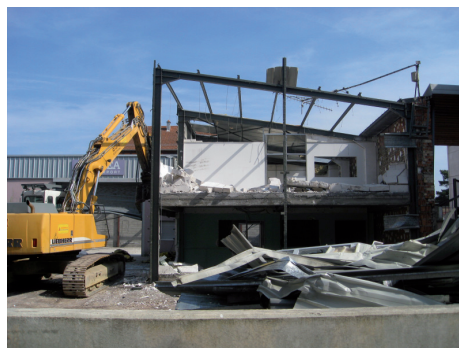
Démolition d'un entrepôt désaffecté Rue des Chaudronniers (avril 2010)
