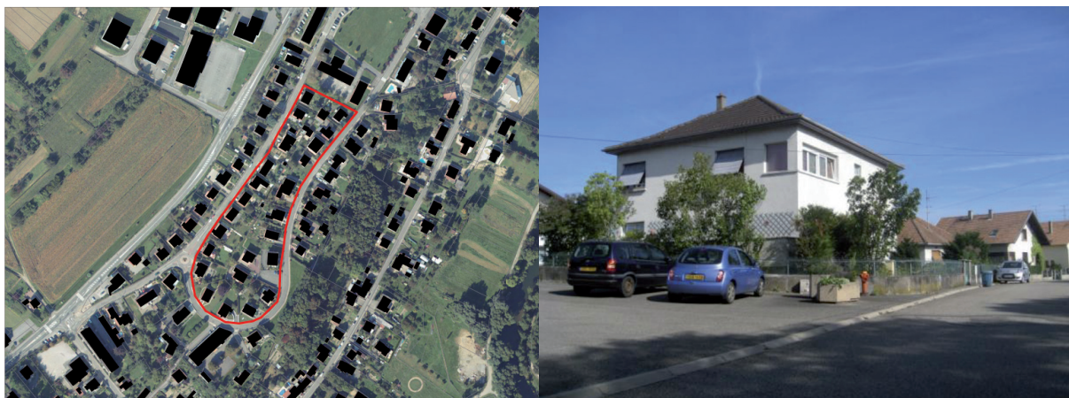
Lotissement (années 1980), Rue Bellevue/Rue des Cigognes, Didenheim : 16 logements/ha
