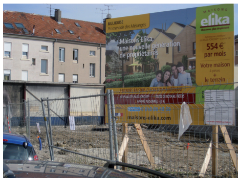
Travaux des maisons de ville Elika rue des Mésanges (avril 2010)
