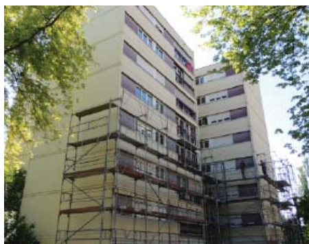
Chantier de la rénovation thermique BBC de la copropriété Delacroix
