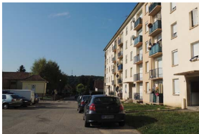
La copropriété IDEE, à Didenheim, est composée de 4 bâtiments, dont 1 est très éloigné des 3 autres. Elle a fait l'objet d'un ambitieux programme de rénovation énergétique avec l'appui de la Région, de l'Anah et de m2A.
