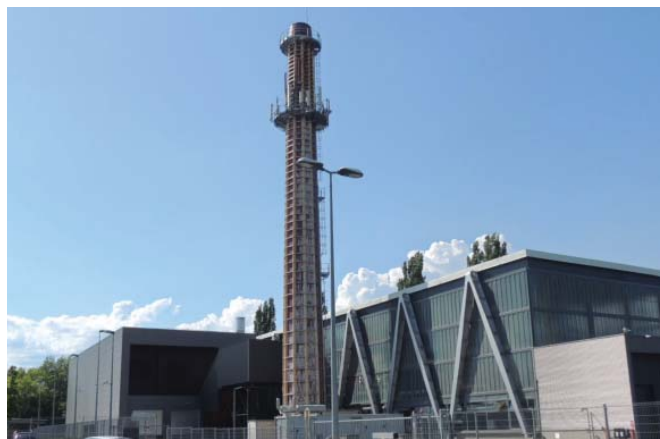
Construite en 1962, la centrale thermique de l'Illberg permet notamment de chauffer les 3 400 logements du quartier des Coteaux.
