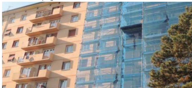
La copropriété Alsace Azur, rue de Bâle, à Mulhouse. Des travaux de rénovation thermique financés par la Région, l'Anah et m2A, se terminent.
