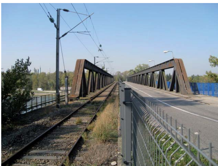
Pont de Chalampé Source : AURM
