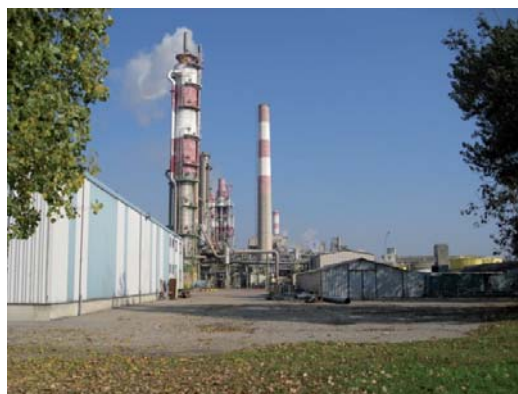
Usine chimique, Chalampé Source AURM
