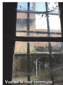
Vue sur la cour commune
