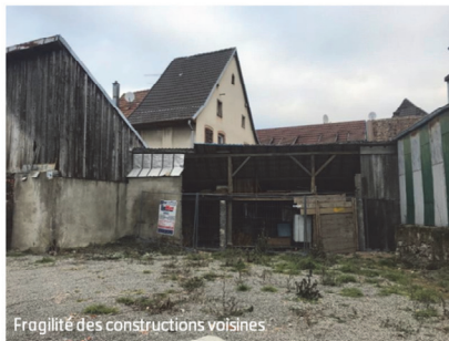
Fragilité des constructions voisines
