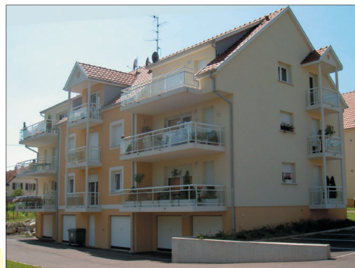
Uffholtz, construction neuve à proximité du centre village
