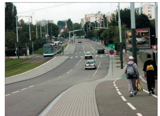
Strasbourg, exemple d'aménagement de voirie ; séparation des flux
