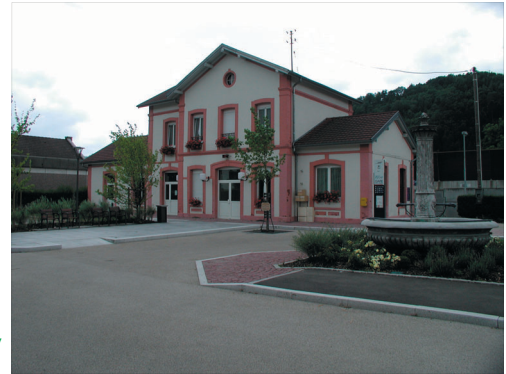
Gare de Saint-Amarin, aménagement de l'espace public
