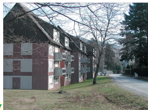
Husseren-Wesserling, logements sociaux
