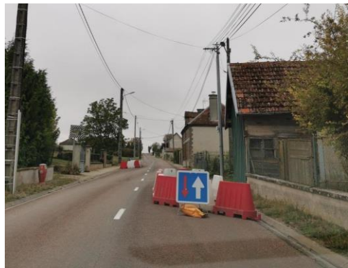
Ecluse provisoire - phase de test
