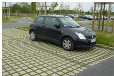
Pavage avec joint gazon ou minéral drainant
