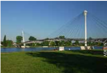
Port du Rhin – Passerelle Mimram au Jardin des Deux Rives
