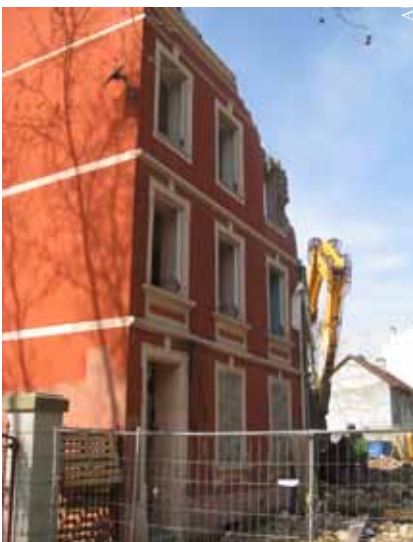
Wolf-Wagner-Vauban-Neppert– Démolition d'immeuble rue des Chaudronniers
