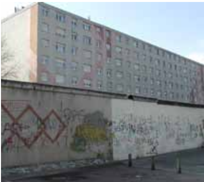
La Thur et Markstein– Immeuble de logements sociaux -Markstein-
