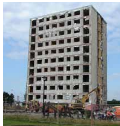
La Thur et Markstein– Démolition de la Tour Zorn -Thur-
