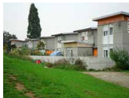
Neuhof – Nouveaux pavillons Cité des Aviateurs
