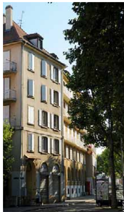
Port du Rhin - Immeuble de logement social
