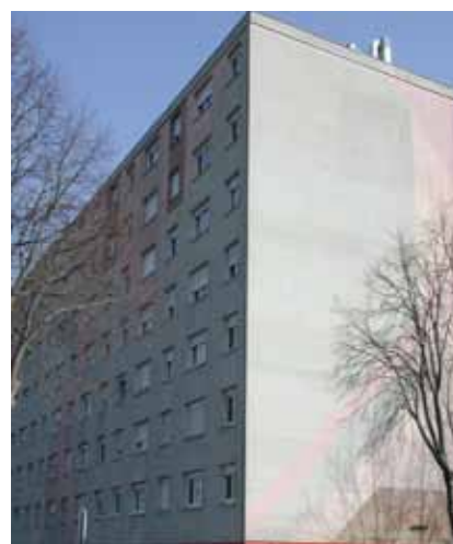
La Thur et Markstein– Immeuble de logements sociaux -Markstein-
