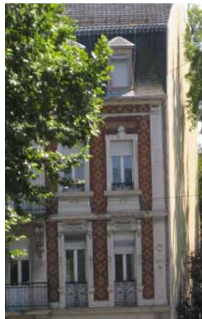
Porte du Miroir– Détail d'un immeuble rue du Raisin
