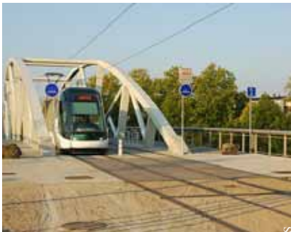
Montagne-Verte – Nouvelle passerelle piétons-tramway
