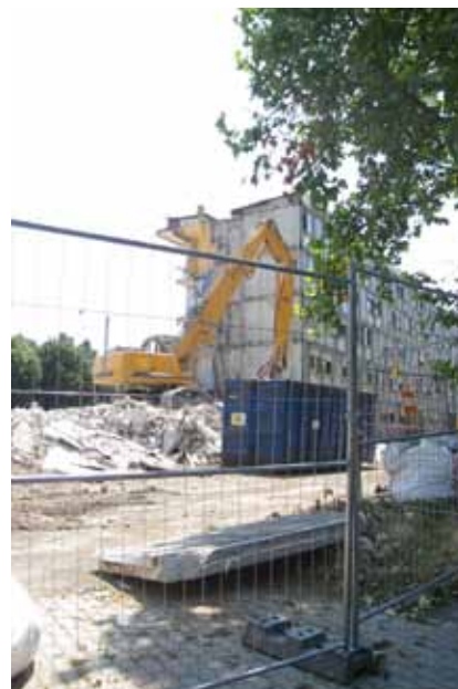
Bourzwiller – Démolition des 420
