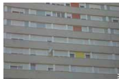
Coteaux – Détail de façade
