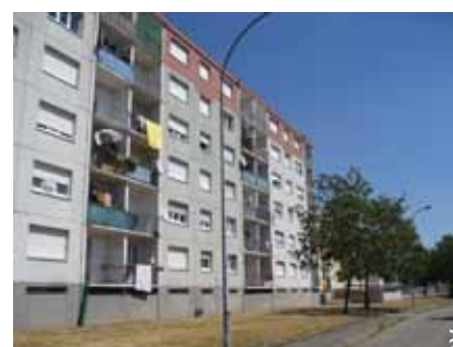
La Thur et Markstein– logements sociaux
