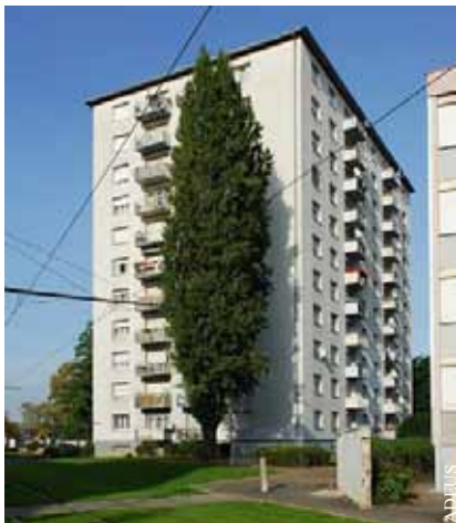
Neuhof – Tour de logements sociaux
