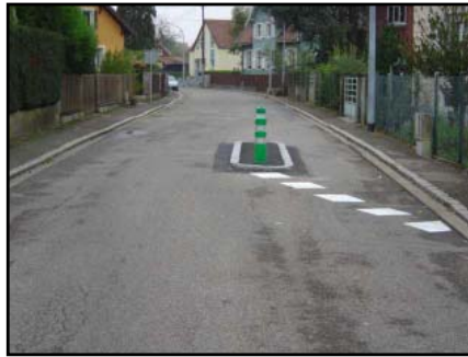
Lutterbach-écluse rue de Morschwiller
