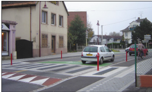
Bollwiller - rue de Sultz
