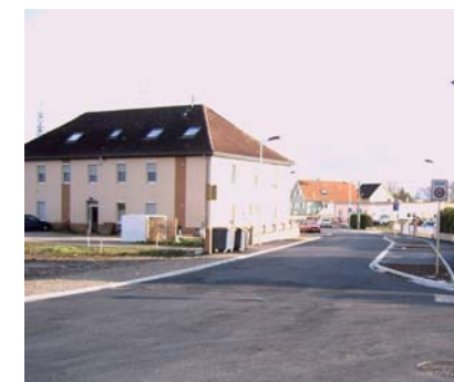
Zone 30 rue de la gare à Staffelfelden
