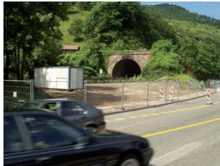
Les travaux de démolition du tunnel de Thann-Nord
