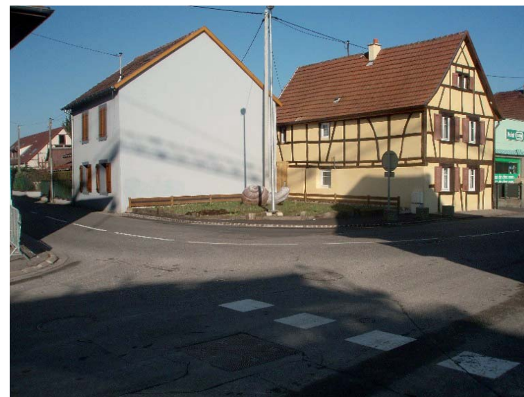
Aménagement du carrefour rues Jeanne d'Arc et de Hochstatt à Zillisheim
