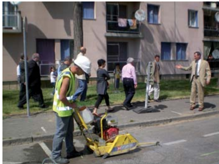
Le chantier d'extension du tramway à Bourtzwiller
