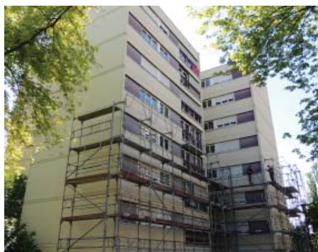
Chantier de rénovation thermique BBC de la copropriété Delacroix, aux Coteaux
