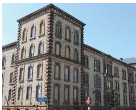
La Caserne Lefebvre, vaisseau-amiral de la rénovation urbaine à Vauban-Neppert
