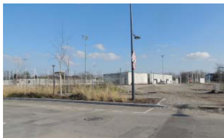
A Bourzwiller, les équipements de la Plaine Sportive et de Loisirs de la Doller sortent progressivement de terre.
