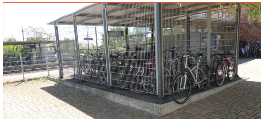
Gare de Rouffach : des vélos sont accrochés aux grilles de l'abri vélo en raison du manque de places disponibles sur les arceaux en accès libre.
