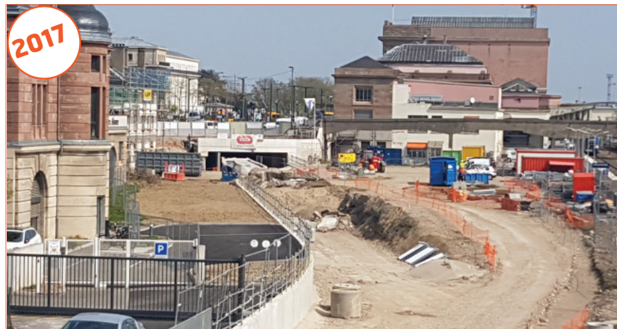
La voie sud - Tunnel de la gare
