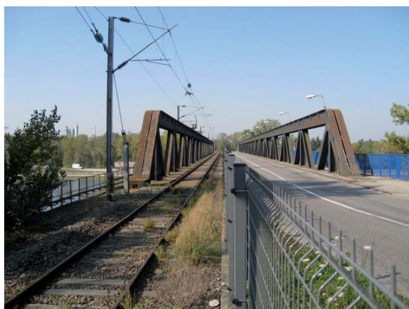
Pont ferroviaire de Chalampé Source : AURM
