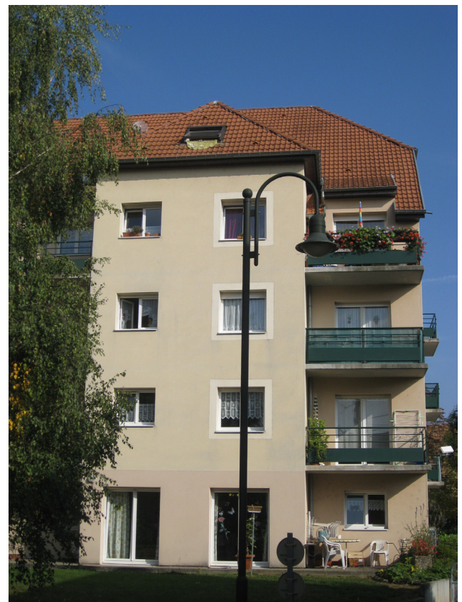
Logement social - Avenue d'Altkirch, Brunstatt
