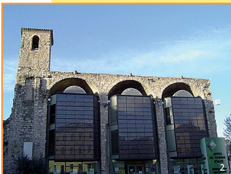
Panneaux solaires photovoltaïques implanté sur les murs de l'office du tourisme d'Alès (30)
