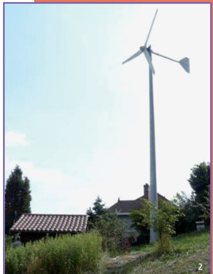
Eolienne implantée sur une parcelle privée des Monts du Lyonnais
