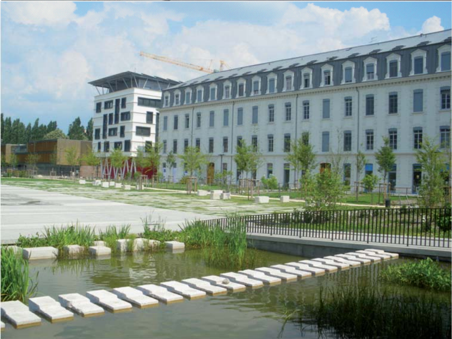
ZAC de Bonne à Grenoble , sur le site de l'ancienne caserne de Bonne; Requalification de l'ancienne place d'honneur en place publique, bâtiments restaurés aux normes BBC et immeuble de bureaux à énergie positive (ci dessous). Photographies de Romain JAVOUREZ, mars 2010 (haut), juin 2010 (bas)
