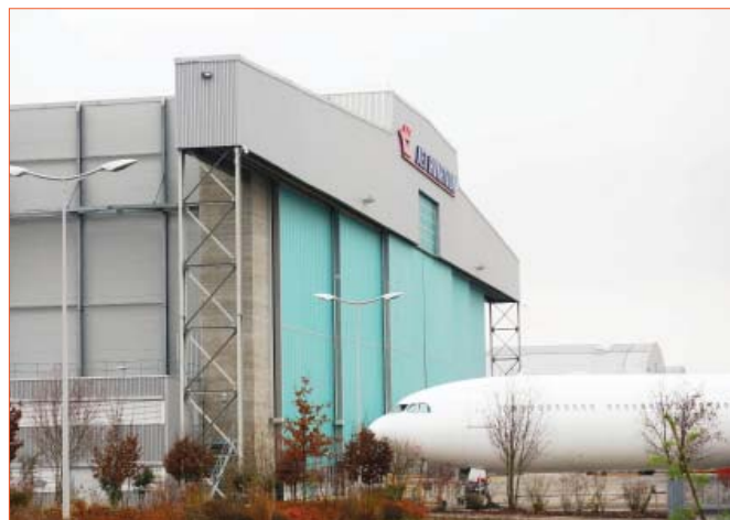
Depuis 2008, Jet Aviation dispose de l'un des plus grands hangars d'Europe dédié à l'aménagement intérieur des avions capables d'accueillir les gros porteurs A380.
