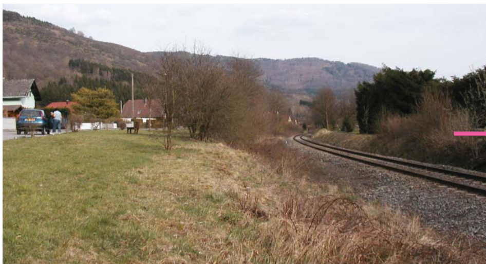
Le site de la gare nouvelle de Ranspach en 2003 - Source : SNCF DTER
