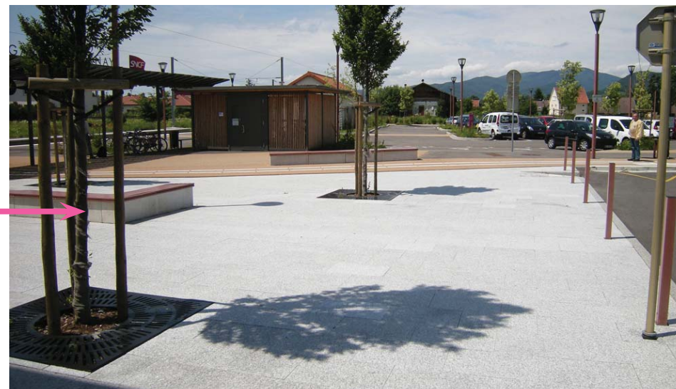
Vue parking nord en 2012
