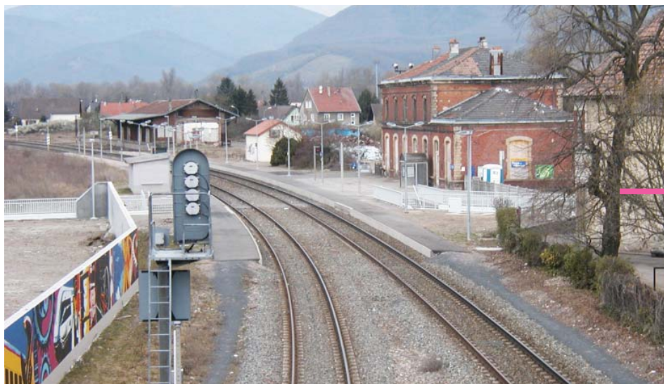
Vue générale en 2003 - Source : SNCF DTER
