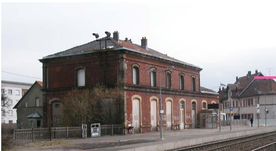
Vue bâtiment voyageur 2003 - Source : SNCF DTER
