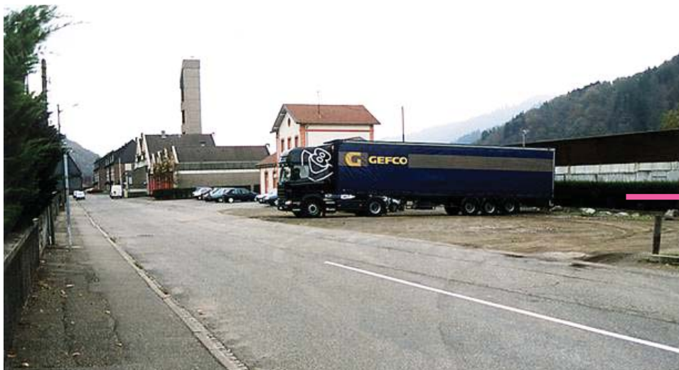
La gare de Saint-Amarin en 2000 - Source : SNCF DTER
