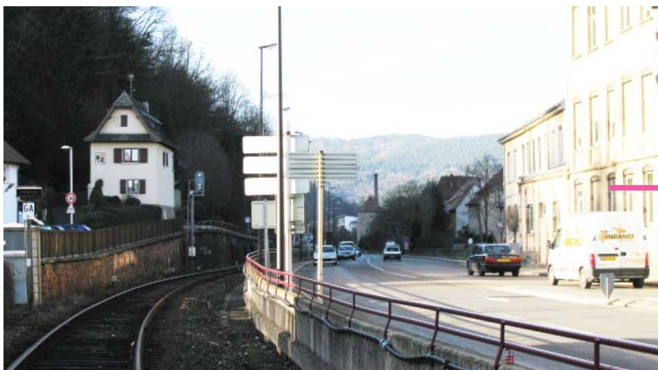
Vue côté quai en 2007
