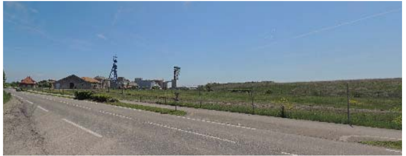
Côté RD 20 IV, l'approche de la zone est marquée par le chevalement qui domine l'ensemble du site
