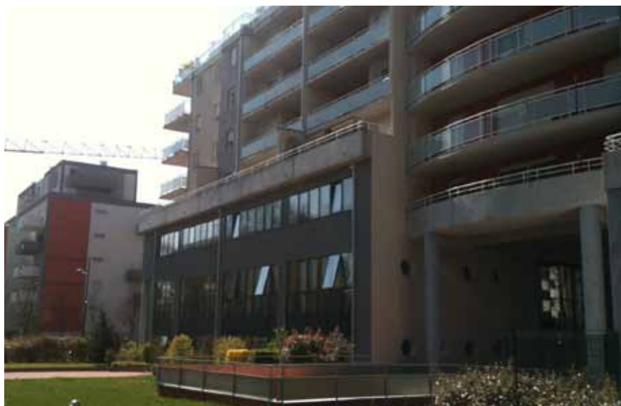
Nouveau Bassin, coeur d'îlot
