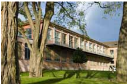
Façade Est du bâtiment
