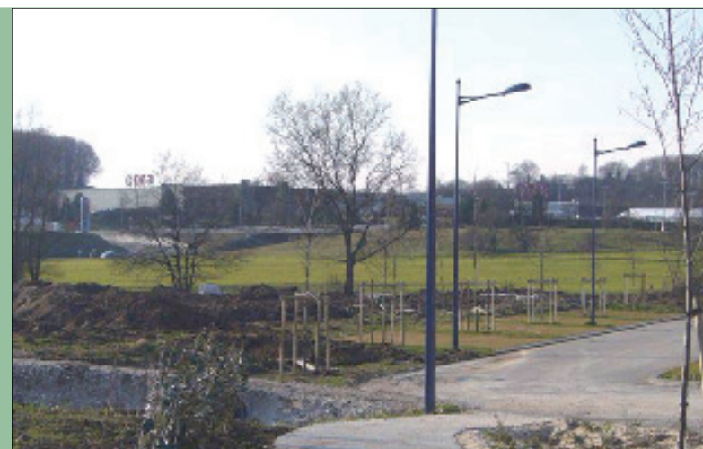
Site de la future zone commerciale : entre CORA et le parc
