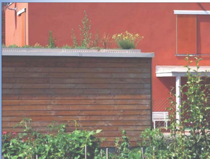
Les toitures végétalisées des garages
