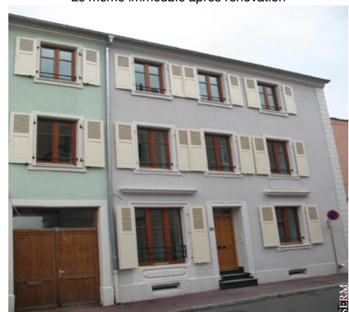
Le même immeuble après rénovation
