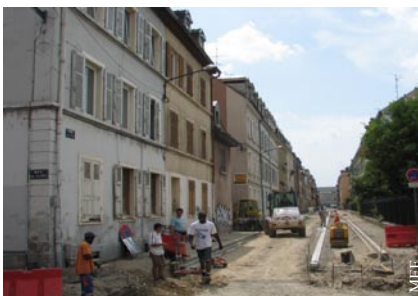
Chantier de réhabilitation de la rue du Runtz, dans le quartier Franklin : les travaux publics et les bâtiments représentent les principaux gisements en heures d'insertion.
