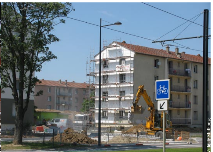
Travaux de résidentialisation dans l'îlot Picasso Été 2010 Quartier de Bourtzwiller
