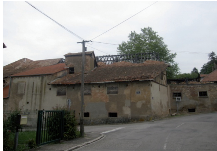
Figure 1: Grange en mauvais état à Morschwiller-le-Bas – Photo AURM
