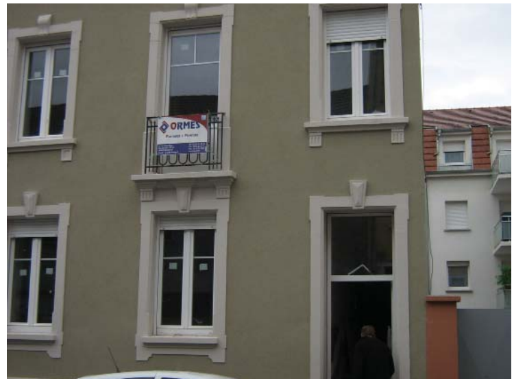
7 rue Zierdt à Mulhouse (à gauche: avant travaux, à droite après travaux réalisés par Néolia dans le cadre d'IGLOO)
