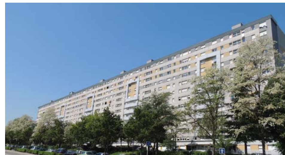
Le parc social du quartier des Coteaux affiche parmi les niveaux de loyer les plus faibles de l'agglomération mulhousienne.
