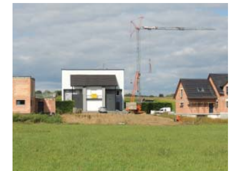
Maisons en construction à Steinbrunn-le-Bas.
