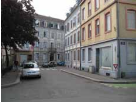
Les immeubles de logement populaire typiques du secteur d'habitat ancien. Un rez-de-chaussée commercial, deux étages et des combles.
