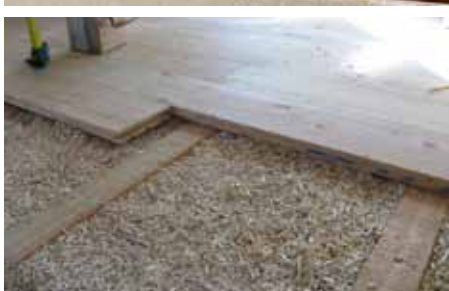
Des matériaux biosourcés du sol au plafond. Ici l'utilisation du bois, du chanvre et de la paille en structure et en isolation. | Sources : eco2scop.fr, musterhaus.net
