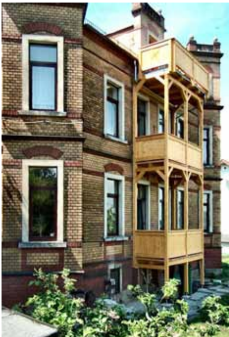
Balcons en ossature légère rapportée en façade pour étendre les logements vers l'extérieur. Source : Holztechnik Lätzsch GmbH
