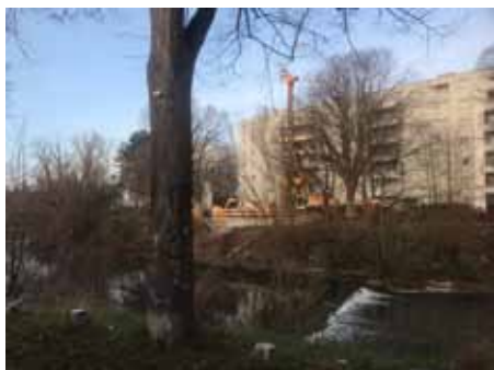
Passerelle en construction au-dessus de l'III. Le quartier Fonderie bientôt mieux accessible en tram et modes actifs.
