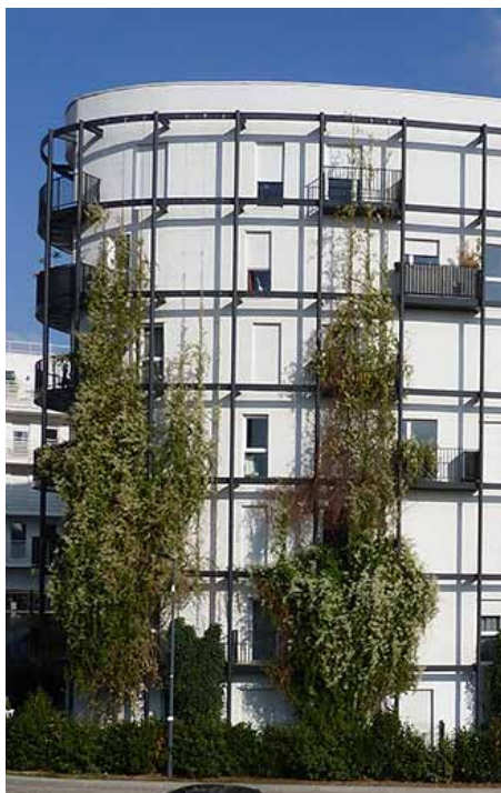
Végétalisation des façades par structures rapportées. | Source: Institut Paris Région (Flickr)
