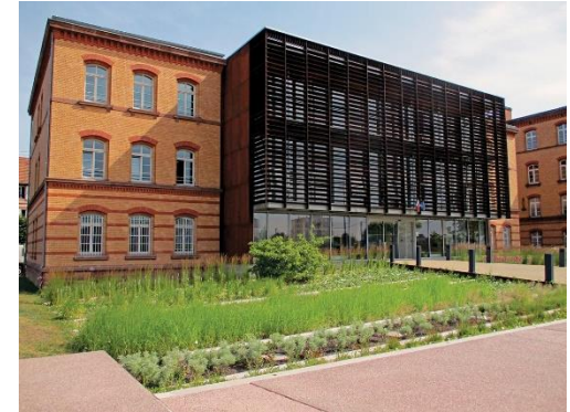
Ecoquartier Thurot à Haguenau sur l'ancienne caserne militaire
