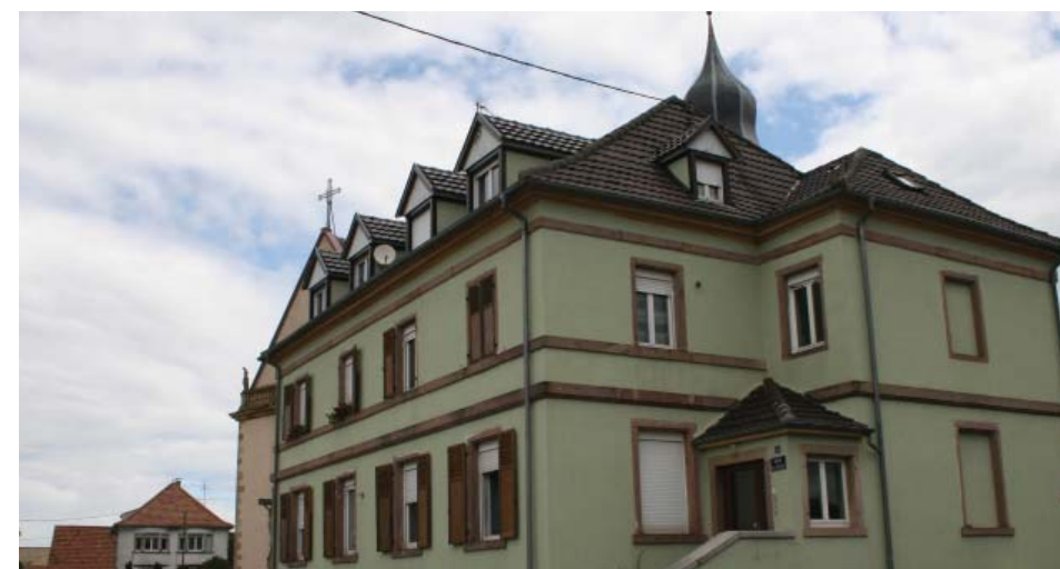
A Ungersheim, une ancienne école a été réhabilitée et transformée en immeuble de logements sociaux
