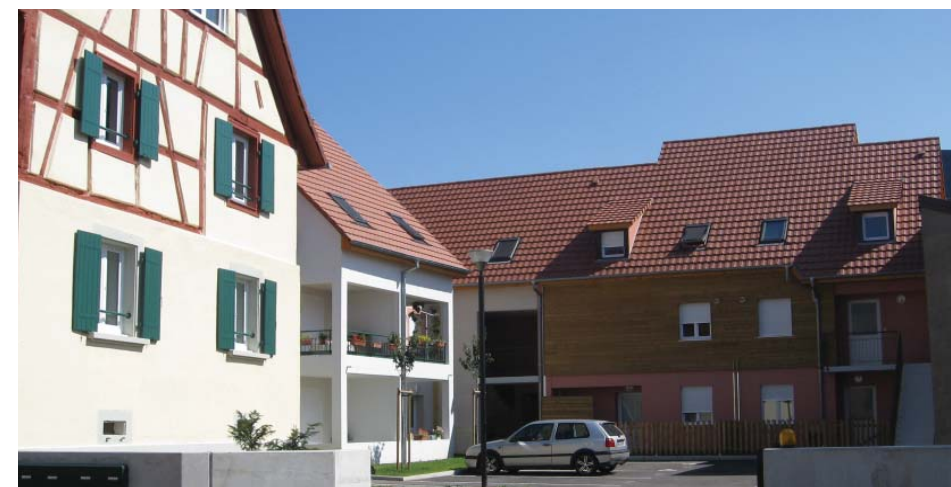
La cour Zurbach, à Reiningue : la réhabilitation d'un corps de ferme et de la construction neuve ont permis de créer 15 logements au coeur du village.
