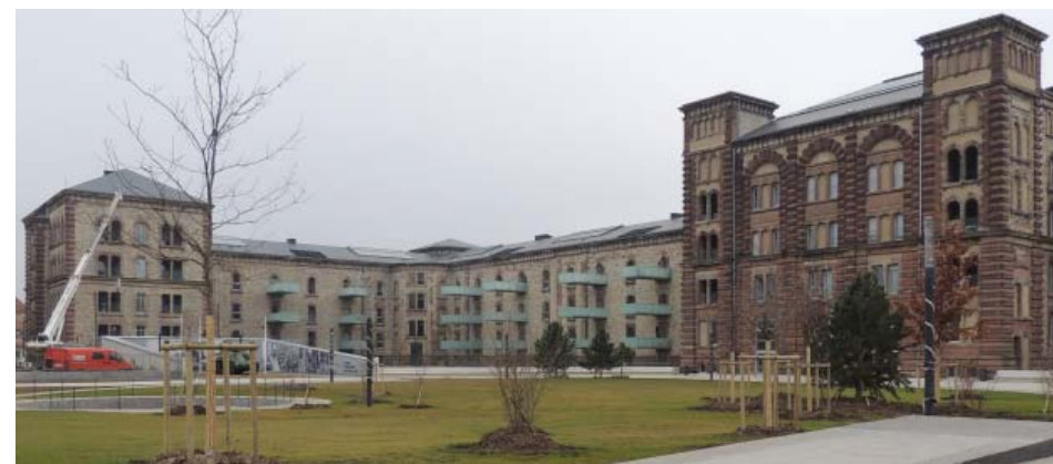
Portée par Batigère, la rénovation de la Caserne Lefebvre, dans le quartier Vauban-Neppert, a permis la création de 108 logements sociaux et d'un grand parc.
