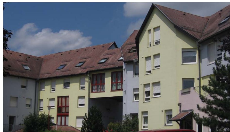
Logements sociaux situés rue des Navettes, à Sausheim.
