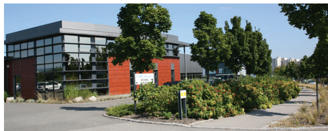
C'est un «beau» parc d'activité, mais ses concepteurs ne sont pas allés au bout de la logique. Il n'est accessible qu'en voiture, ce qui repousse certaines entreprises et mécontente celles déjà installées car les parkings font défaut.
