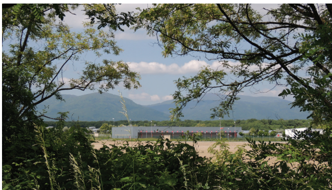
Une zone d'activité en périphérie de l'agglomération, entre deux communes, sans desserte en transports collectifs et sans services pour les salariés... Résultat, des espaces aménagés n'ont pas trouvé preneur et un grand bâtiment vide ne trouve pas de repreneur.
