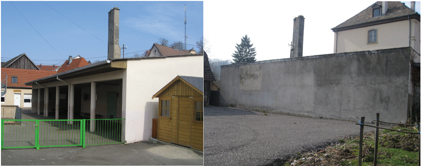
Le préau, qui sépare la cour de l'école de la cour de la maison Landwerlin
