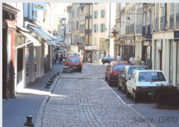
Les chicanes réalisées par un stationnement alterné
