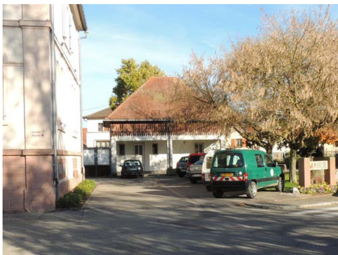
Les ateliers communaux composés des toilettes et du lieu de stockage...
