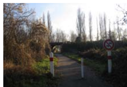
Cheminement à renforcer
