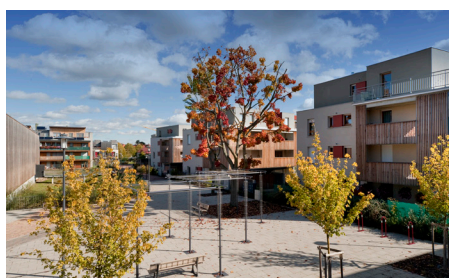
Logements sociaux à Mulhouse (écoquartier Wagner)
