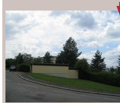
7- Les pavillons sont limités en hauteur et pour certains sont insérés dans la pente.
