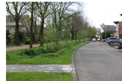
Breda (NL) : noue végétalisée
