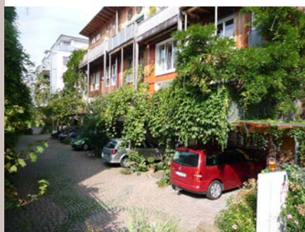
Freiburg (D) : Les pieds d'immeubles accueillent du stationnement dissimulé sous la végétation abondante.
