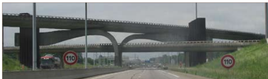
Echangeur autoroutier entre l'A35 et l'A36 : une barrière infranchissable pour certaines espèces animales nécessitant des aménagements de passages à faune, Sausheim
