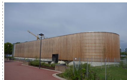
Mulhouse (68) - Stationnement en silo en limite de l'opération Wolf Wagner; il regroupe le stationnement et protège le quartier du bruit et des vues depuis la rue de la Mertzau.
