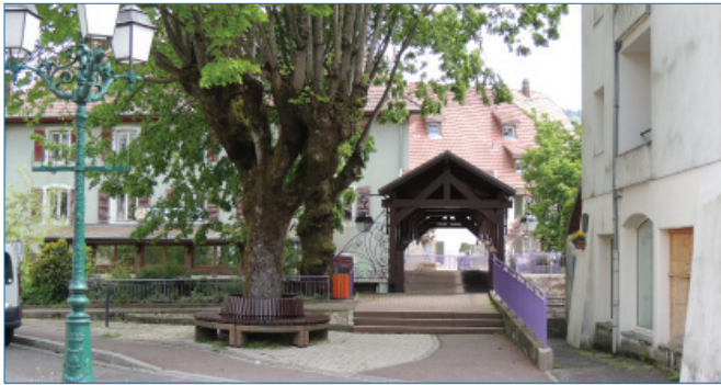
Masevaux : passerelle piétonne pour traverser la Doller
