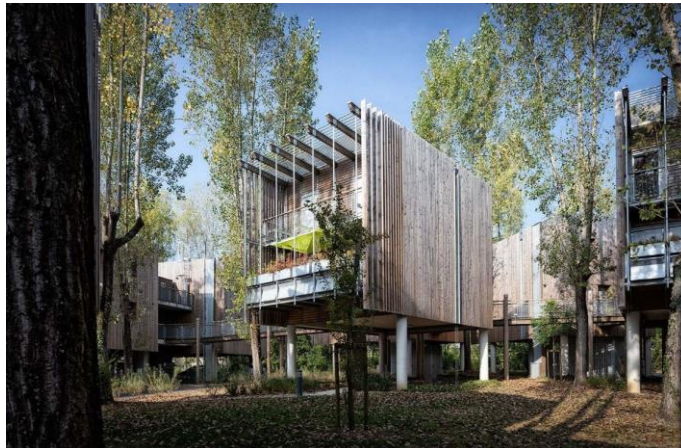
Bâtiment sur pilotis sans destruction de sol à Bayonne Source Patrick Arotcharen – Marc Barra
