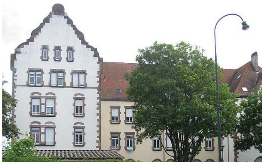
La caserne Barbanègre acquise pour 1,8 millions d'euros est entièrement dédiée à l'habitat avec 500 logements réalisés, pour un investissement total de 8 millions d'euros
