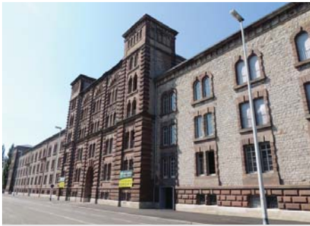
La ZAC Lefevre, point d'ancrage de la rénovation urbaine du quartier
