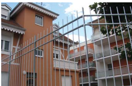
Des logements sociaux neufs ou réhabilités contribuent à rajeunir un parc social assez ancien
