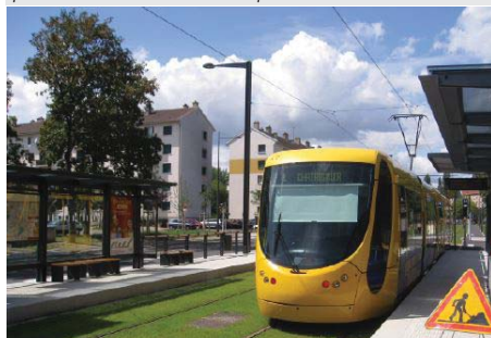
Le tramway, fil rouge du projet urbain mulhousien, dessert l'ensemble du quartier
