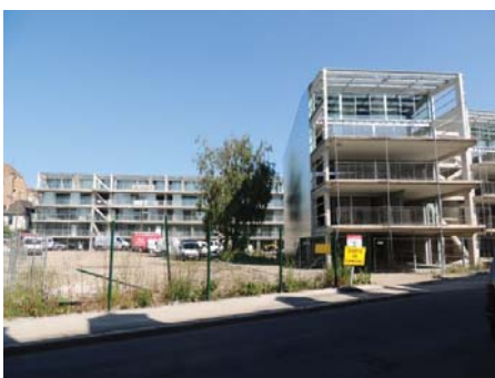
Construction de logement sociaux au coeur du quartier Vauban-Neppert (opération de la SOMCO rue Buhler)
