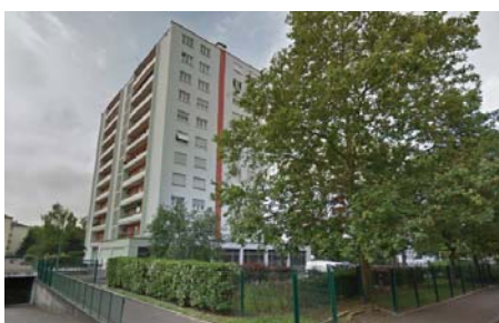
Les logements font l'objet de travaux d'isolation et de rénovation des systèmes de chauffage afin de limiter les dépenses énergétiques
