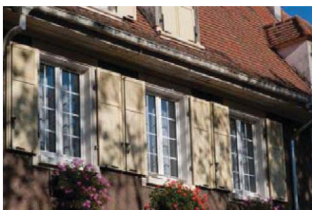
Un patrimoine bâti ancien de bonne facture
