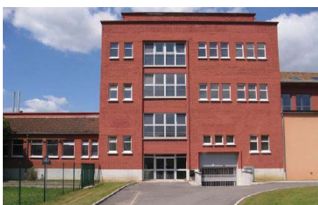
Entrée des lofts Manurhin. Un projet emblématique de la nouvelle image de Bourzwiller
