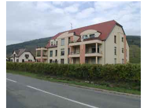
Bâtiment collectif à l'extérieur de l'enveloppe urbaine à Kientzheim
